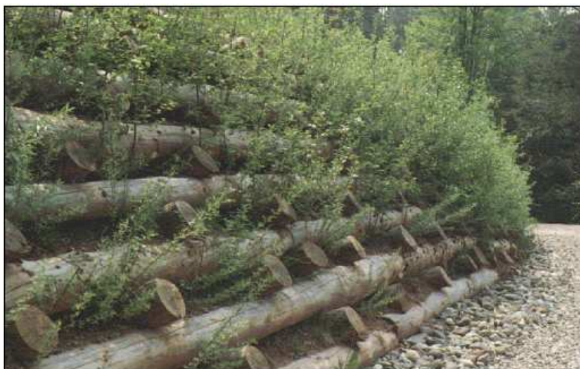
Fig. 7 – Esempio di opera d'ingegneria naturalistica. Palificata doppia di sostegno alla scarpata
